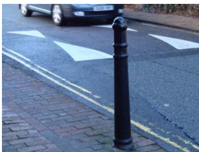
I I a. Simple cast iron bollard
